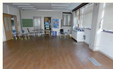
改修前の活動室
